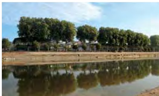
Cale en tablier du port de la Pénine à Orléans.
