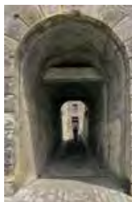
Passage vicié dénommé « la Charente » enjambé sous la route, rue droite, à environ soixante mètres en aval du pont de pierre. Propriétaires au fleuve, ce passage permet une communication directe entre la ville et la Loire. Construit durant la campagne de travaux de 1778 par l'ingénieur Normand, il a été comblé lors des réaménagements de 1820. Un passage comploté est également visible sur la commune de Jargau (Loiret).
