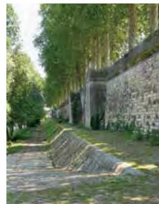
Cale double à tablier bas de Beauregard. Les cales doubles à tablier haut ou bas sont des ouvrages composés de deux rampes d'accès à l'eau. L'une orientée vers l'amont, l'autre vers l'aval. Les deux rampes sont reliées par une plateforme haute ou basse. Ces ouvrages sont typiques des années 1840 et sont généralement situés sur des ports de moyenne importance.
