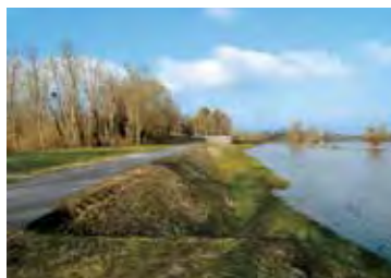
En aval du pont, deux épis et un mur vertical de protection des ouvrages de canal contre les crues de la Loire.
