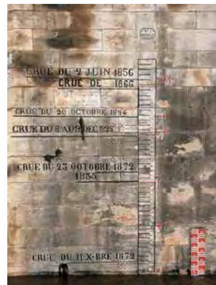
Culée droite du pont Royal à Orléans.
