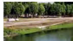
Cale double à tablier bas de Beauregard. Les cales doubles à tablier haut ou bas sont des ouvrages composés de deux rampes d'accès à l'eau. L'une orientée vers l'amont, l'autre vers l'aval. Les deux rampes sont reliées par une plateforme haute ou basse. Ces ouvrages sont typiques des années 1840 et sont généralement situés sur des ports de moyenne importance.
